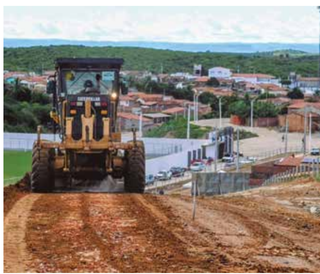
Pavimentação na rodovia PB-370 abrange trecho de 9 km
